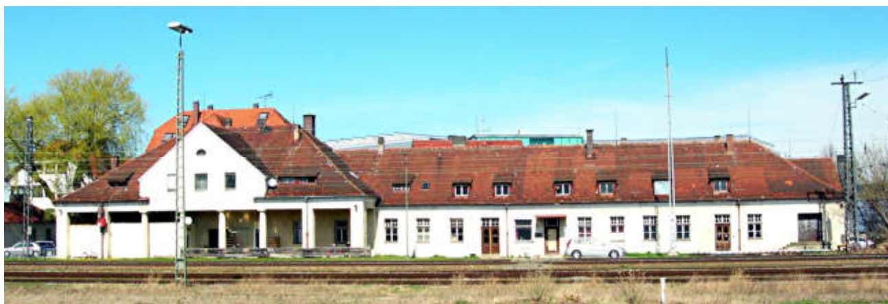
Blick in 2013 auf Lindau-Reutins altes Bahnhofsgebäude vom Jahre 1911 von Süden her.
